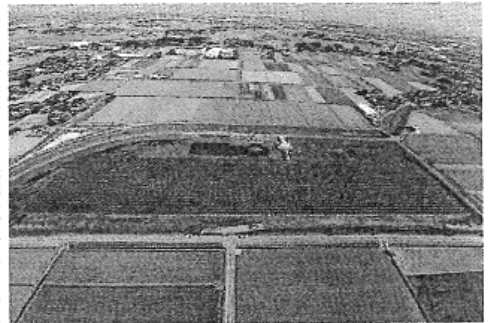
◇バイテック熊谷太陽光発電所 売電事業者＝バイテック、EPC＝栗原工業、企画提案＝イーテクノス（電気工事）＋中村勉総合計画事務所、架台施工＝駒井ハルテック
